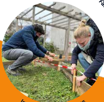
Installation des parcelles
